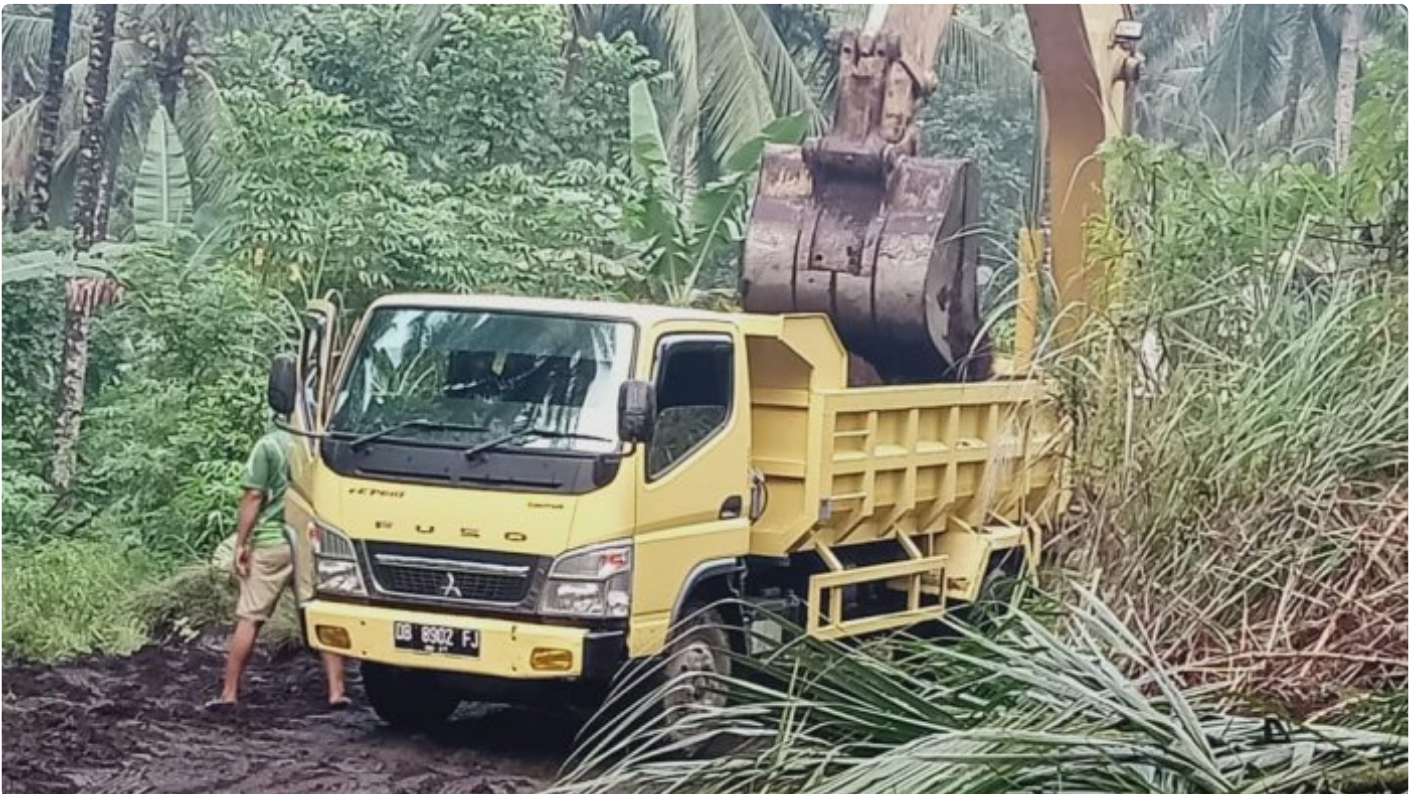
Dump Truk angkut Material Tanah Timbunan Pembangunan Sarana Jogging Track pada TMMD Ke 116 di Kelurahan Tandurusa
