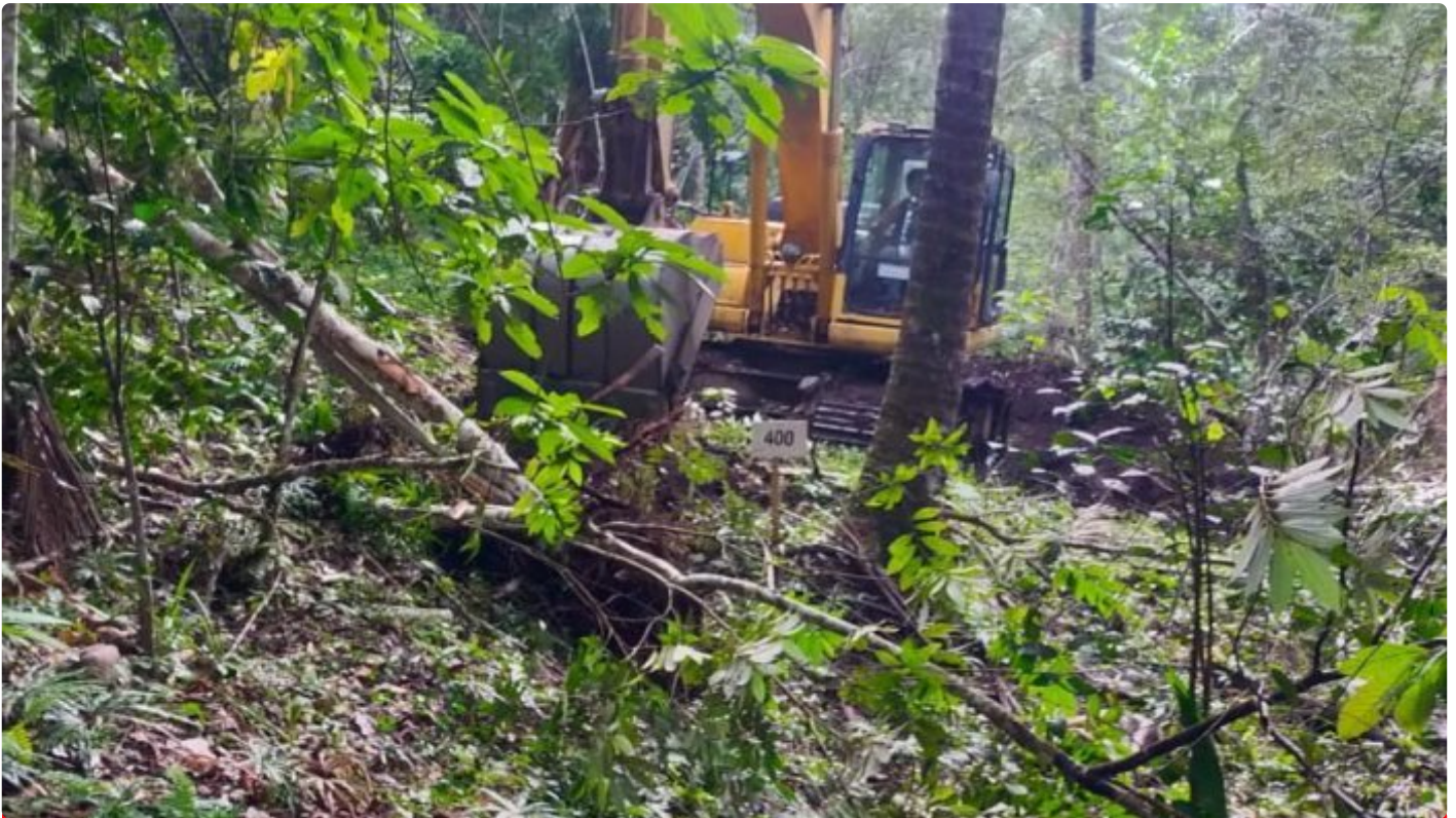
Pekerjaan akses Jalan TMMD Ke-116
